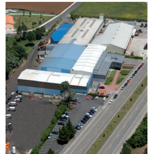
Instalaciones de Industrias Guerra, S.A. Industrias Guerra S.A. facilities
