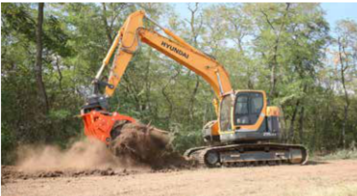
Nettoyage et entretien de vastes étendues de terrain.
